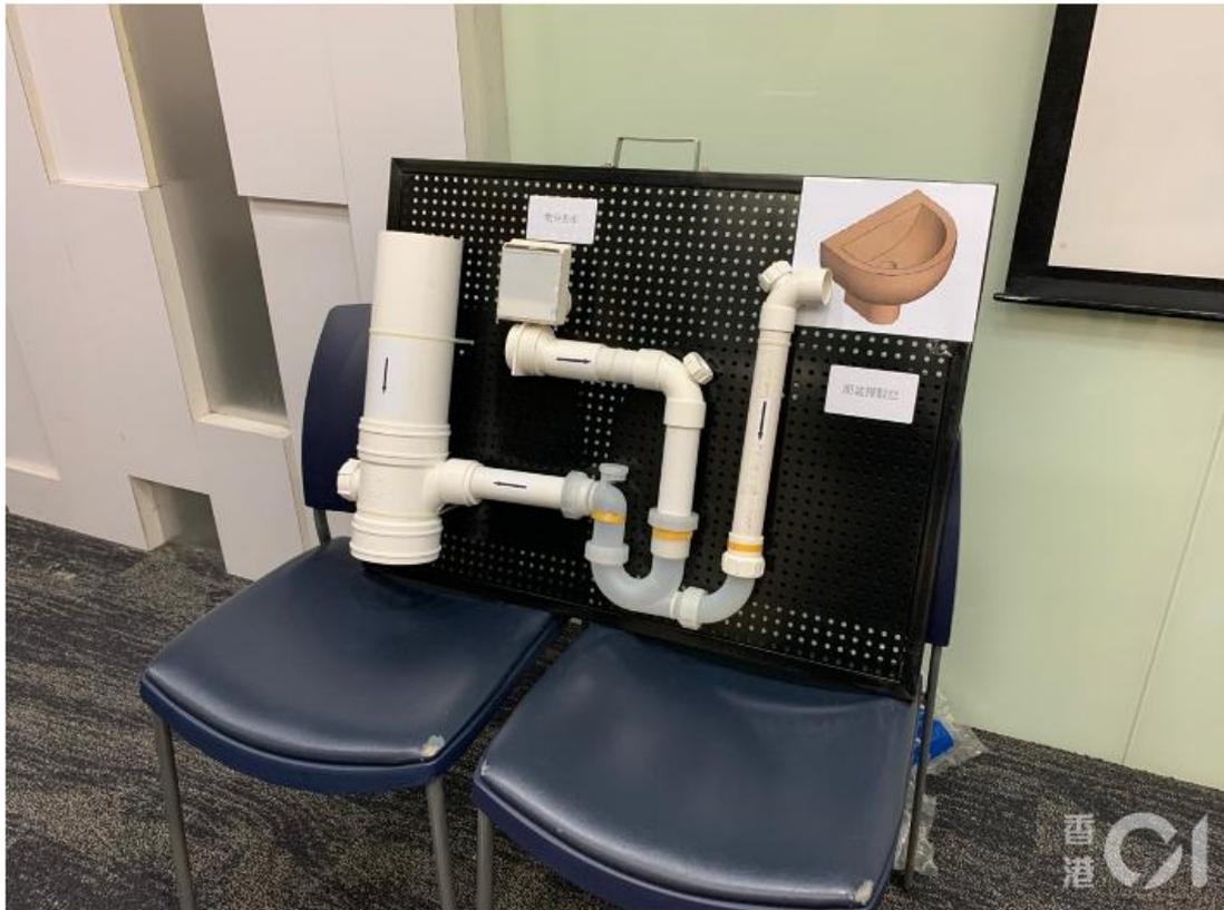
W型隔氣管道將原有隔氣彎管接駁到洗手盤。(張嘉敏攝)
